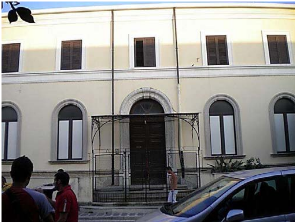
L'ASILO OGGI, RISTRUTTURATO E CHIUSO. E' SCOMPARSO IL PARAPETTO CON L'ANTICA INCISIONE DEDICATORIA
