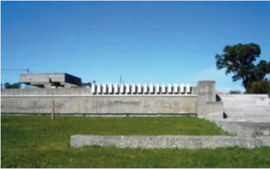
Figura 5 – Il Monumento ai Fratelli Bandiera, località Bucchi. La costruzione è in cemento armato e marmo, progettata dall’architetto Giorgio Volpato, articolata su due livelli. Su un primo piano, a livello della strada, sorge al centro una croce in legno, mentre un piazzale lastricato in cemento conduce, poi, ad una scalinata in marmo che porta al secondo livello. Proprio qui al centro di un basamento in calcestruzzo si trovano 17 blocchi in pietra di Trani dalla forma parallelepipedica volti a rappresentare i 17 patrioti compagni dei Fratelli Bandiera in ricordo del loro straordinario coraggio. Si vedano: Comune di Crotona, Monumento ai fratelli Bandiera , Settore Sviluppo Economico e Politiche Sociali, Giovanili e Culturali, Servizio Beni Culturali, Crotona; Laura Palermo, La percezione dei luoghi della memoria nel contesto urbano di Crotona , tesi di laurea, Dipartimento di Studi Umanistici, Corso di laurea in Scienze della Formazione Primaria, Università della Calabria, Rende, a.a. 2012-2013.
