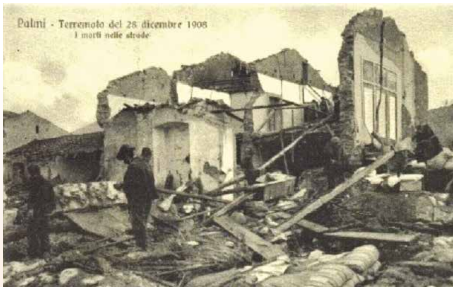
Terremoto di Palmi
