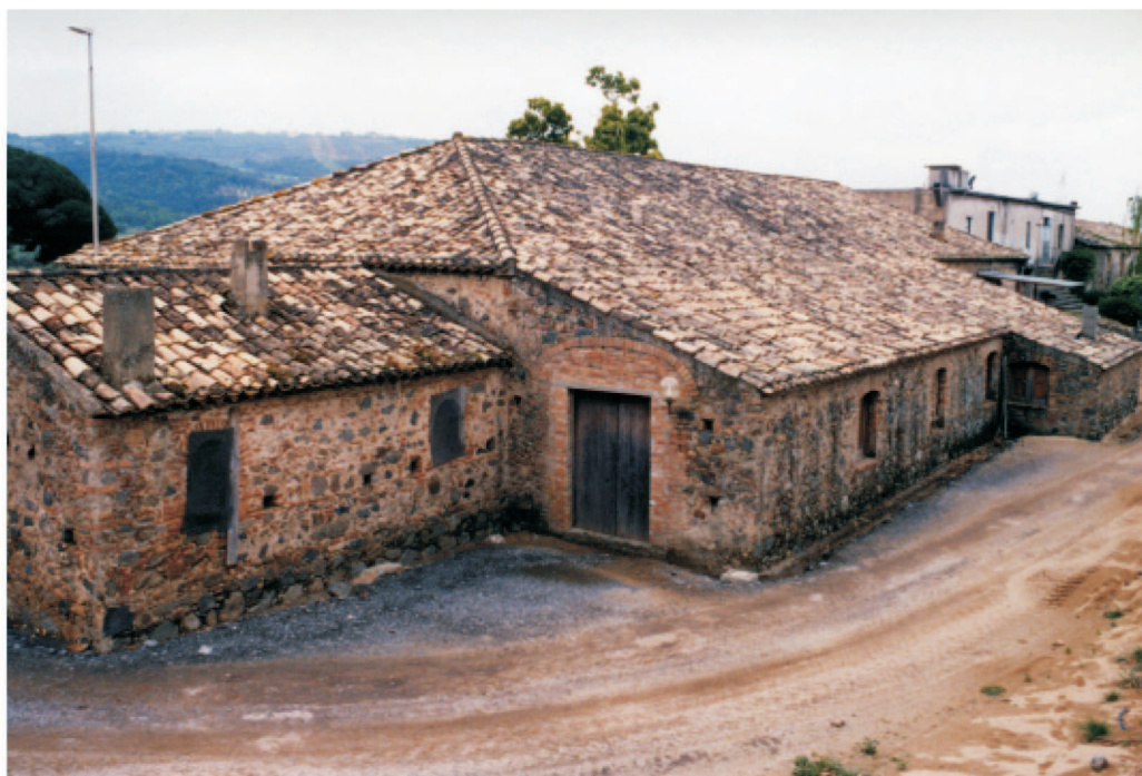
Fig. 12 - Frantoio dei primi anni del XX secolo, costruito nell'ambito del complesso rurale Case Bevilacqua, nel territorio di Curinga (CZ).
