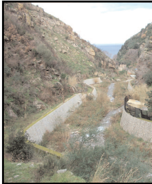
Fig. 4 - Sistemazione con argini del tratto medio della fiumara Sfalassà (prov. di Reggio Calabria).
