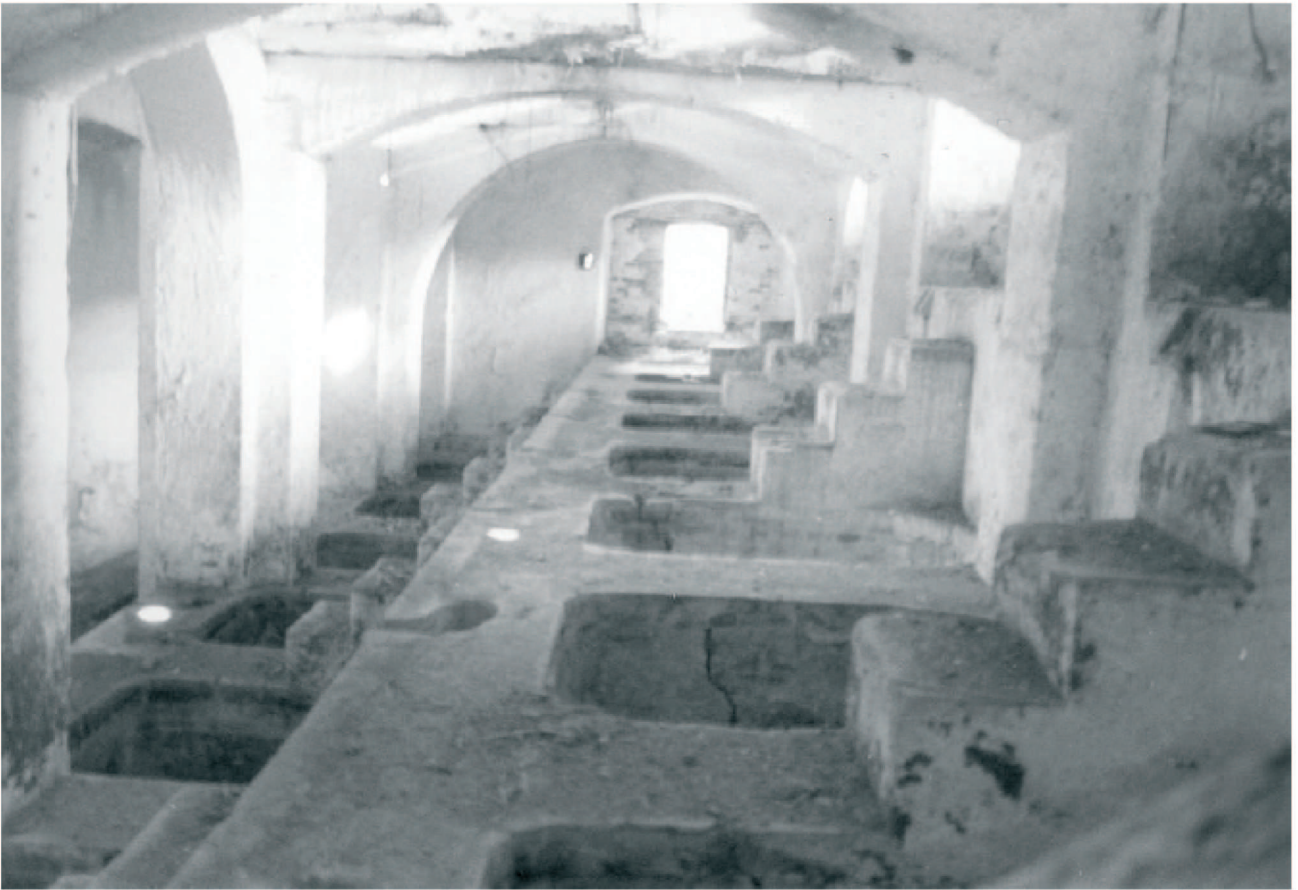
Fig. 5 - Frantoio delle Troffe (Rizziconi, RC): veduta interna del locale utilizzato per la lavatura del nocciolo, con otto file di vasche disposte in parallelo e digradanti secondo sei successivi livelli.
