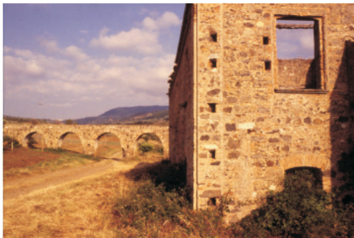
Figg. 8 a,b - Opere di canalizzazione per l'adduzione dell'acqua in un antico oleificio ad azionamento idraulico, di cui in primo piano si vedono i ruderi, nella campagne del Lametino
