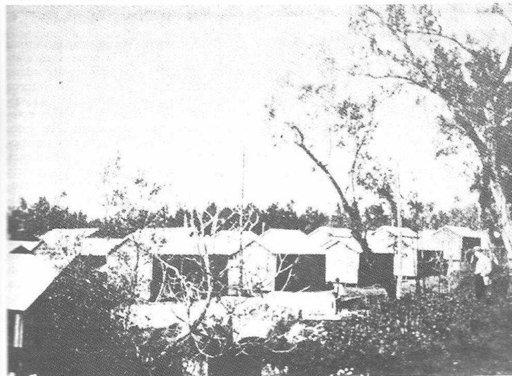
Oppido VI.: Baracche per i terremotati
