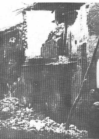
Oppido M.: casa distrutta dal sisma
