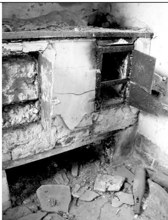
Fig. 7 - Particolare del disegno originale del Banco da Cucina (Concessione MiBac Archivio Centrale dello Stato, autorizzazione n° 1063/2013) ed uno superstite nel 2005.
